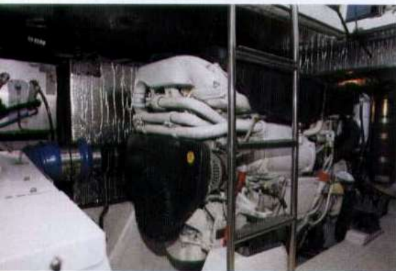
La sala motori ospita due entroboard Volvo Penta da 575 cv con V Drive.
